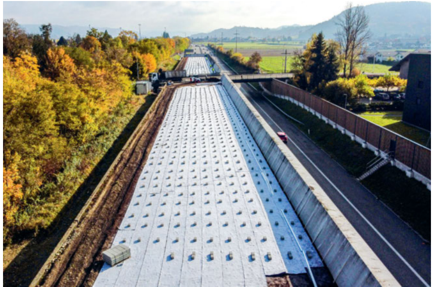
Vorbereitungsarbeiten zur Montage der Module: Die Räume dazwischen werden bepflanzt.
