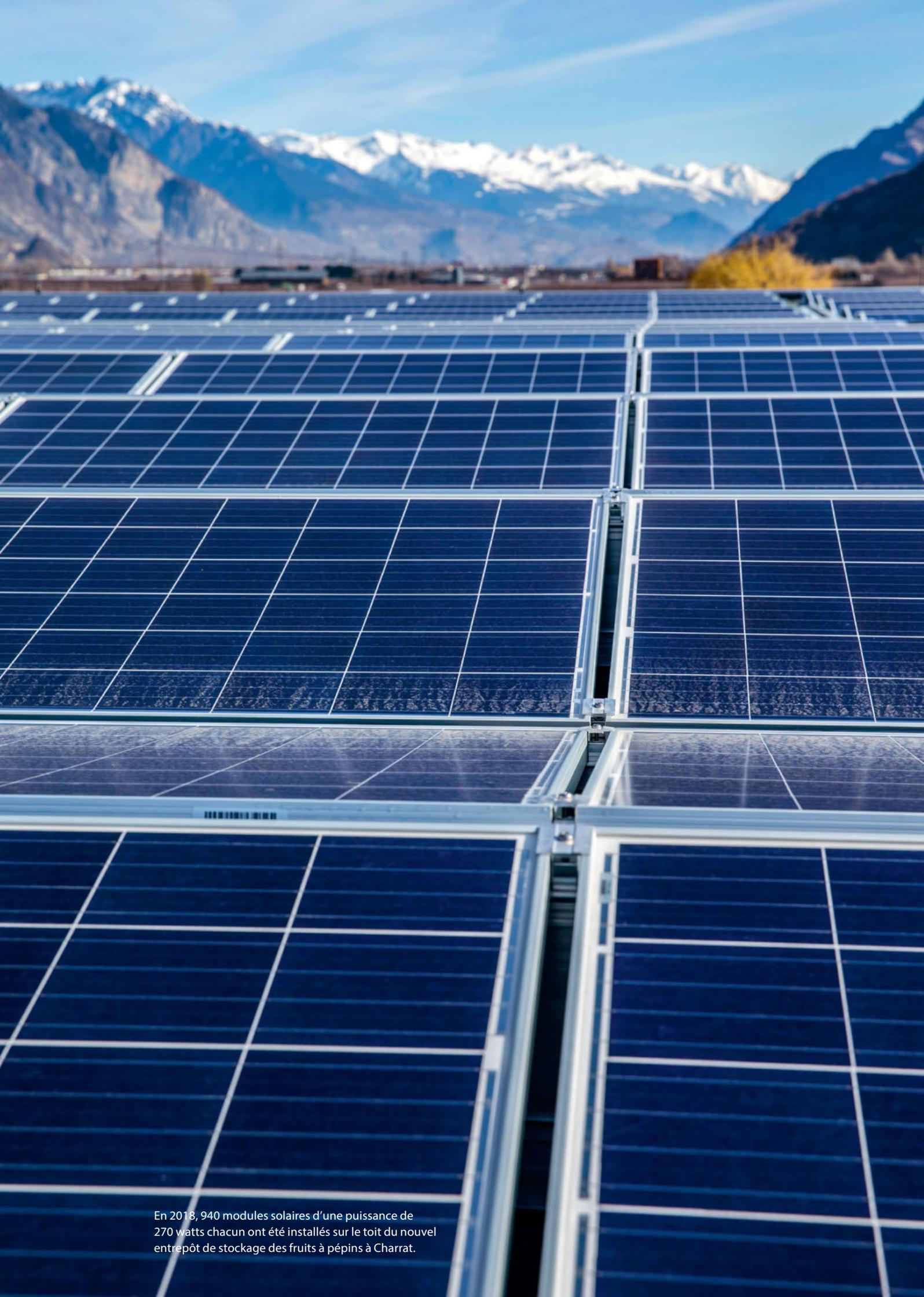
En 2018, 940 modules solaires d'une puissance de 270 watts chacun ont été installés sur le toit du nouvel entrepôt de stockage des fruits à pépins à Charrat.
