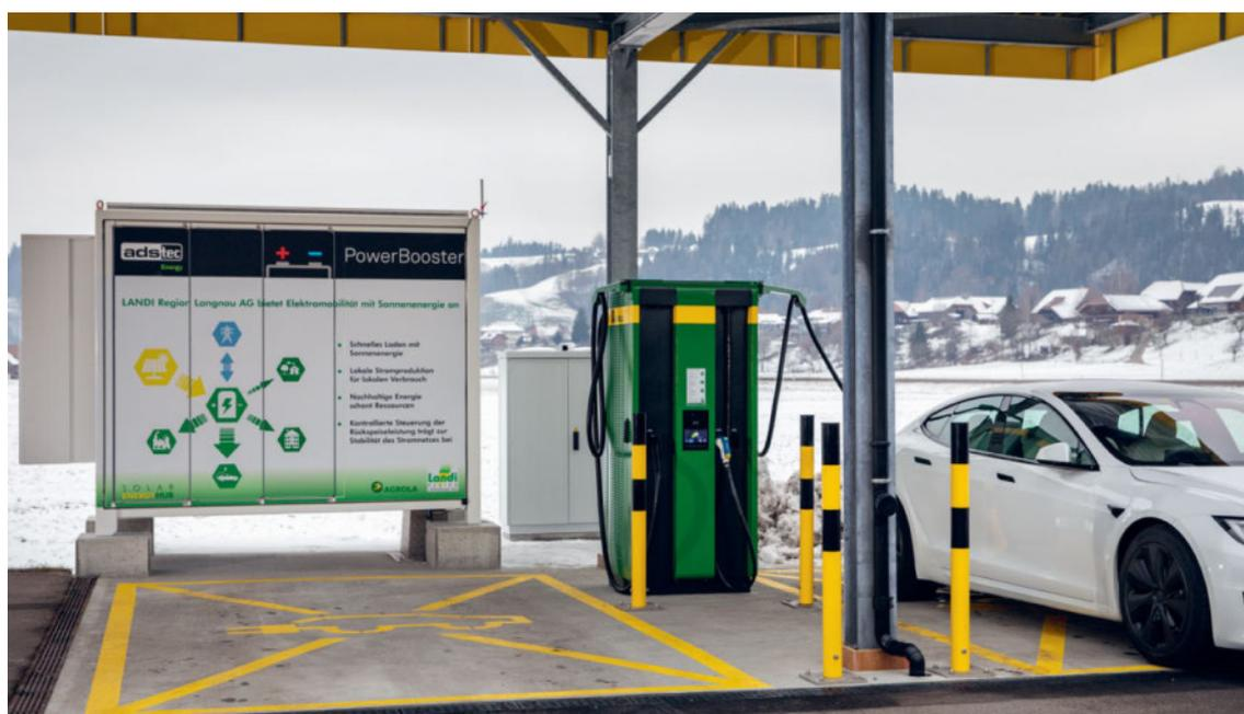
**La borne de recharge rapide de Zollbrück (BE) permet de recharger un véhicule électrique en seulement 15 minutes, pour une autonomie de 250 kilomètres.**
